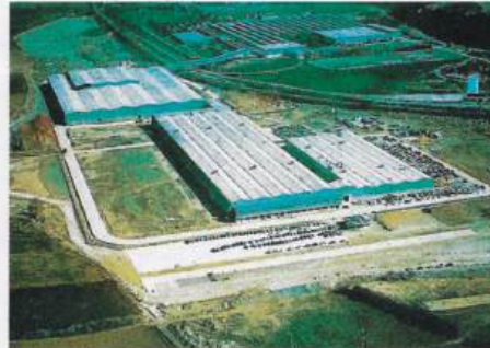
Usine de Pampelune : montage.
