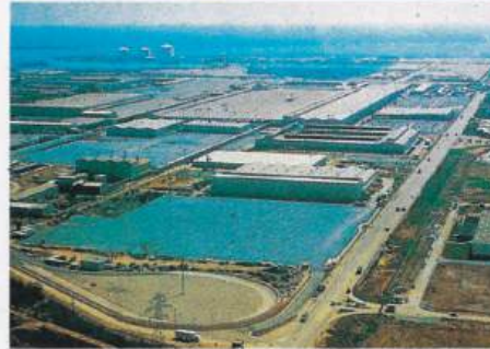
Usine de la zone franche de Barcelone : moteur, carrosserie, montage.
